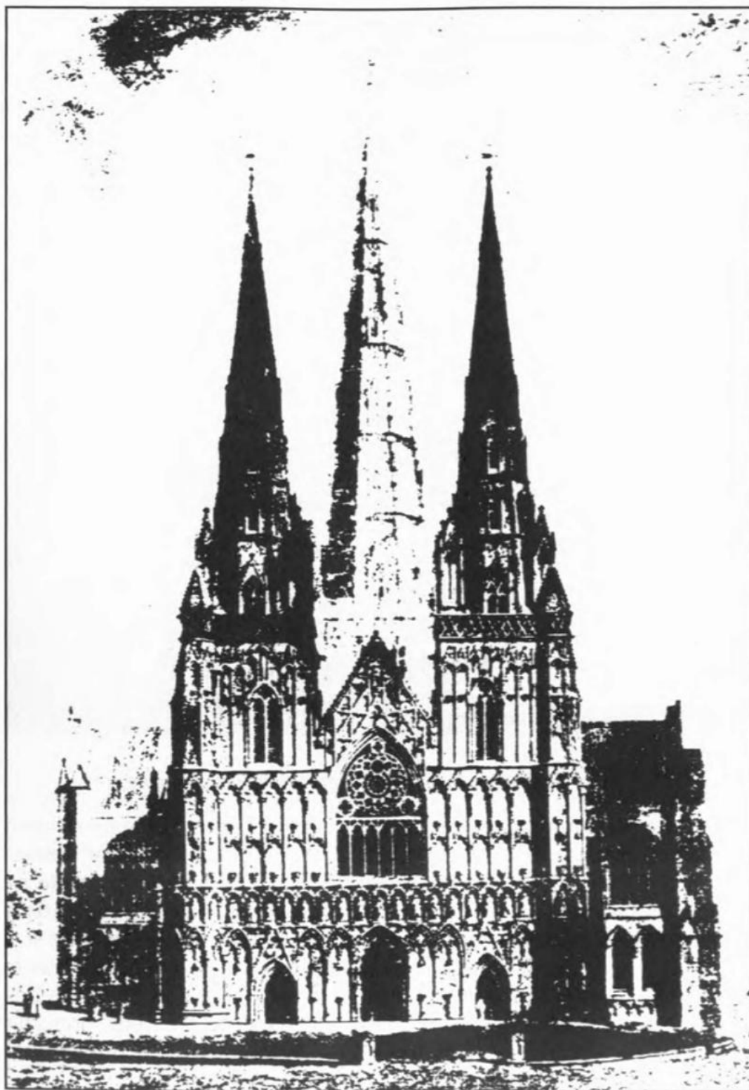
Figura 29 A fachada oeste da Catedral de Lichfield, Inglaterra
